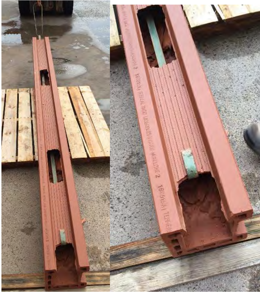
Etape N°1 : inséré le crochet de la tringle de levage dans la fenêtre de 90*90 mm
