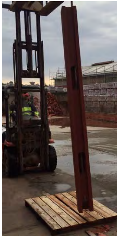
Etape N°2 : lever le produit à l'aide d'un engin de manutention afin de le mettre en place Figure N°2 ter : étape de manipulation
