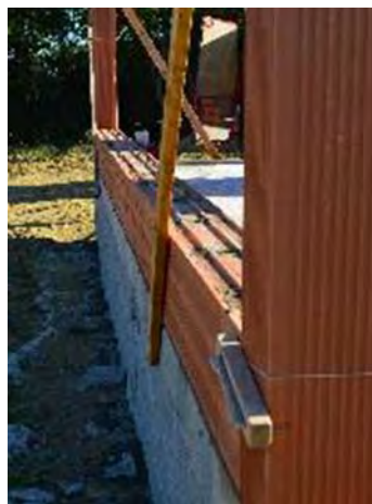
Figure N°3 bis : maintien de l'angle monolithe en cours de montage
