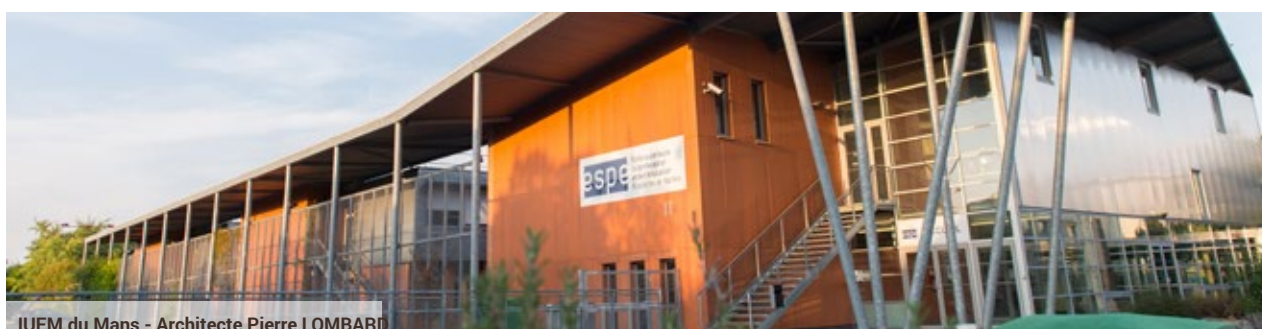
IUFM du Mans - Architecte Pierre LOMBARD
